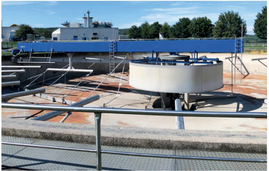
Sanierung von Räumern
