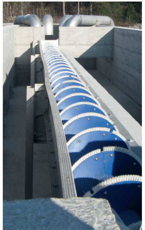
Noggerath® Überlaufsieb OVF für Regenüberlaufbecken
